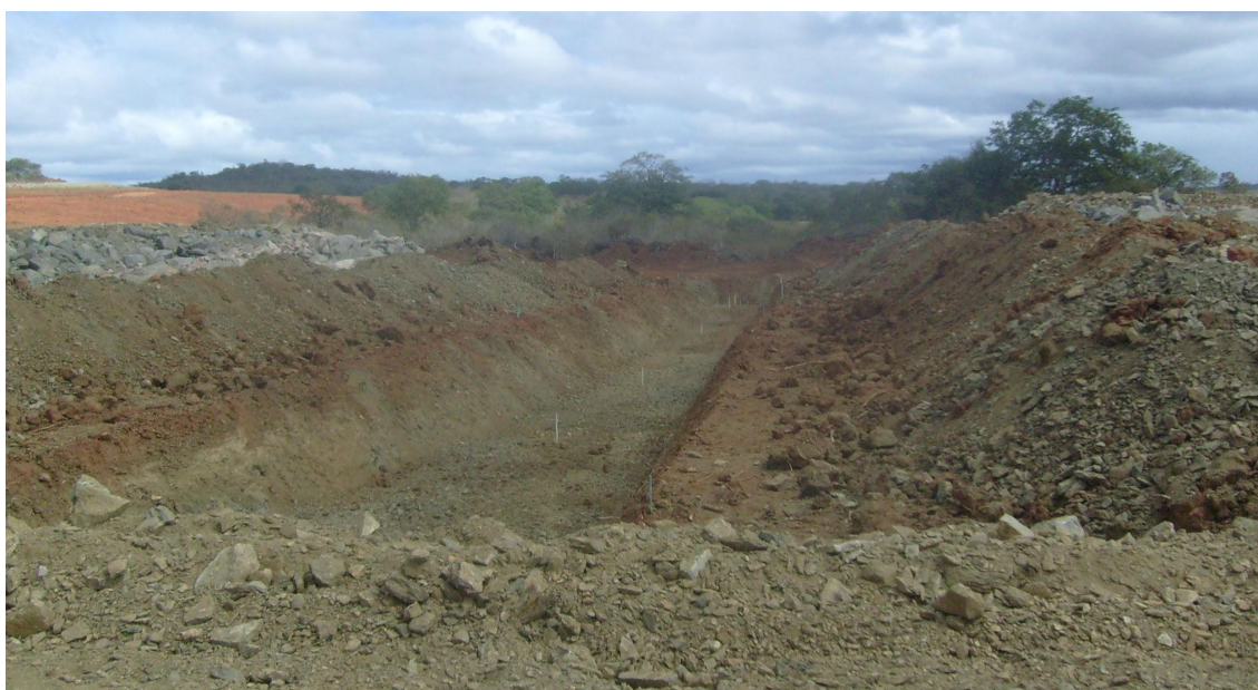
Foto 4: Detalhe da escavação do canal
