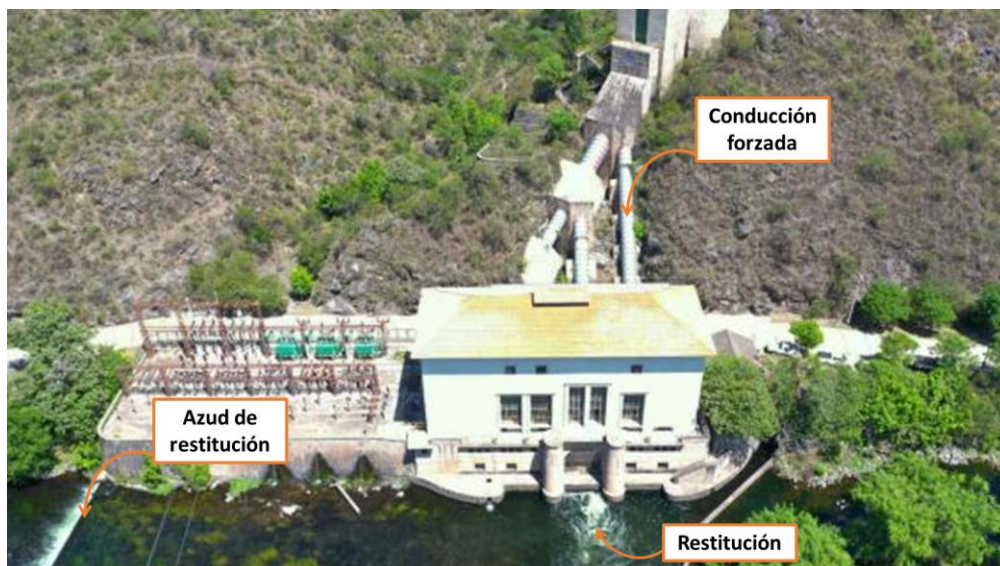
Figura 14. Componentes del Sistema Hidroeléctrico Cassaffousth
