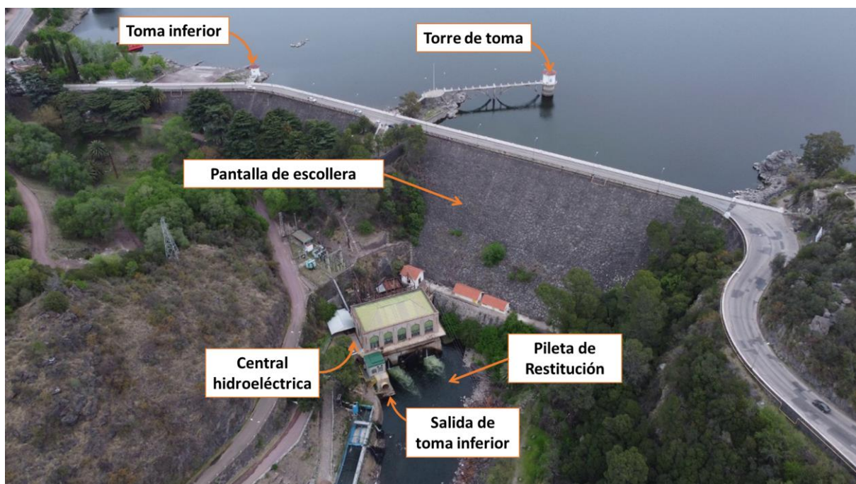
Figura 12: Componentes del Sistema Hidroeléctrico Fitz Simon
